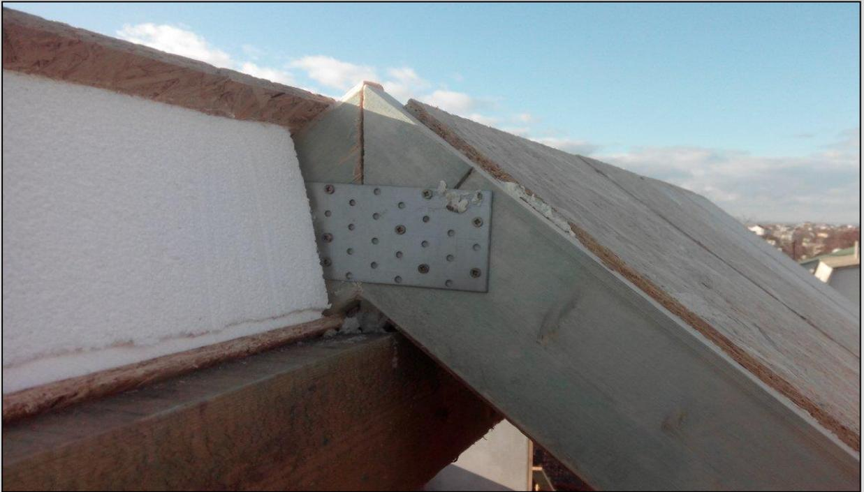
**ФОТО 5 Узел конькового стыка кровельных панелей**
