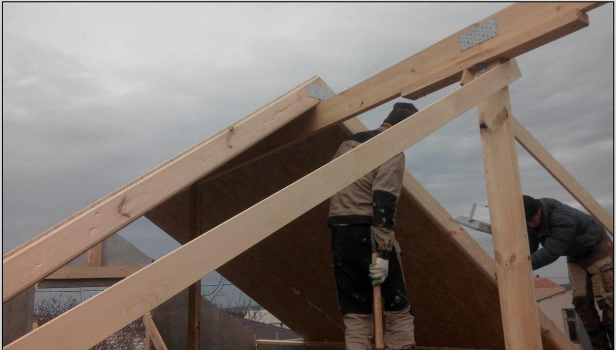
**ФОТО 6 Узел конькового стыка кровельных панелей с применением конькового бруса и поперечных прогонов**
