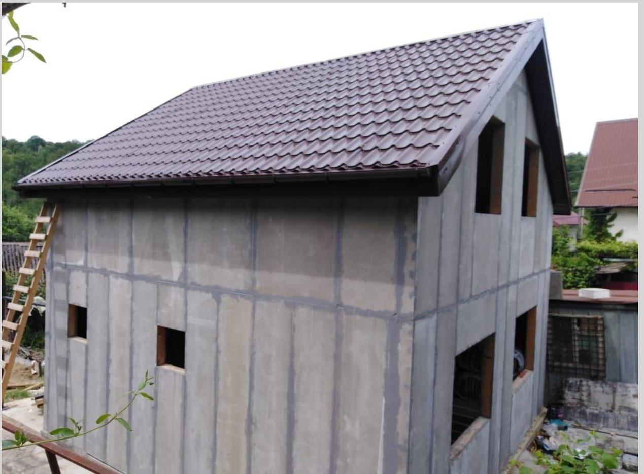
**Фото 8 Кровля с покрытием металлочерепицы**
