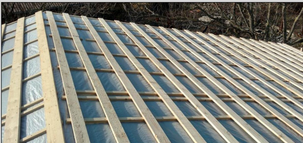
**Фото 3. Ветро-гидозащита и обрешетка кровли**
